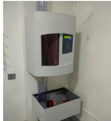
চিত্র-১২ (২): Pneumatic Sample Transport (PST) System এর মাধ্যমে নমুনা গ্রহণ
