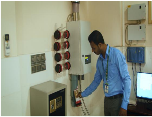
চিত্র-১২ (১): Pneumatic Sample Transport (PST) System এর মাধ্যমে নমুনা প্রেরণ
